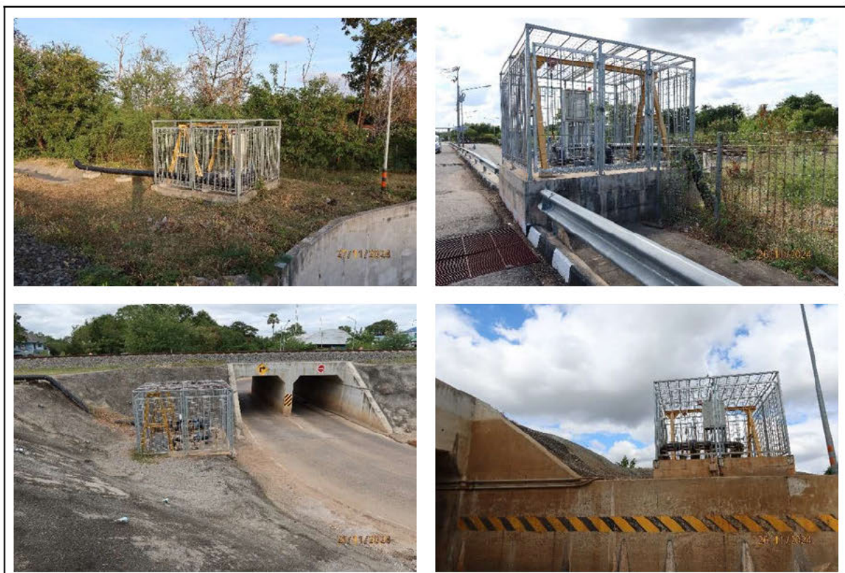
รูปที่ 2.2-17 บั้มสูบน้ำอัตโนมัติในบริเวณที่เป็นทางลอด
