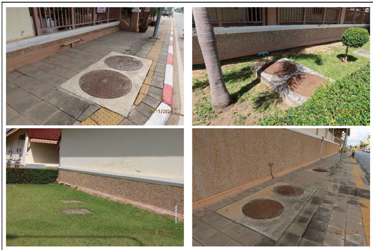
รูปที่ 2.2-2 ถังบำบัดน้ำเสียสำเร็จรูปที่ติดตั้งด้านหลังห้องน้ำของสถานีรถไฟ
